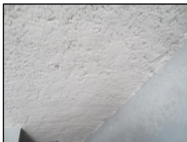
Photo N° 610 ECH-N°2 FLOCAGE -- LOCAL VELO Plafonds Blanc cotonneux
